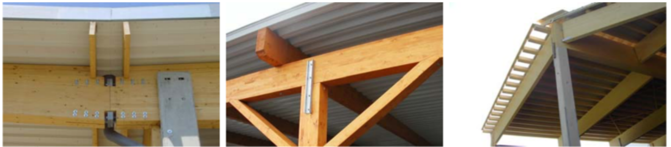
Abb. 10: Randbereiche mit Dachüberstand als Witterungsschutz
