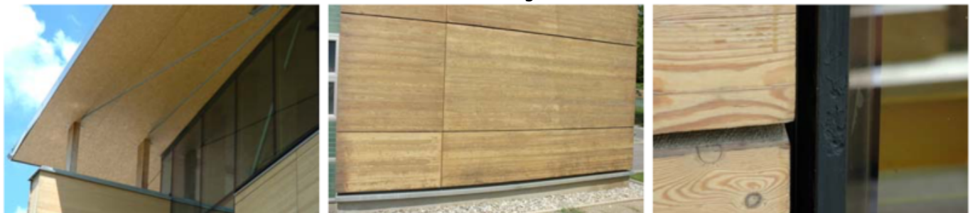
Abb. 11: Vordach mit Stahlunterspannung – Blechabdeckungen der exponierten Bauteile; Holzwerkstoff-Fassadenelemente mit Sockelausbildung (ca. 30 cm); Dichtungsband bei Fassadeneinbauten (Glasfläche)
