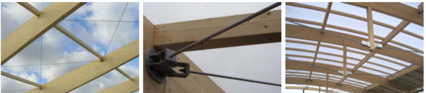
Abb. 8: Stahl-Windverband sowie Anschluss an Holztragwerk; Stahl-Unterspannung eines Bogenträgers aus Brettschichtholz
