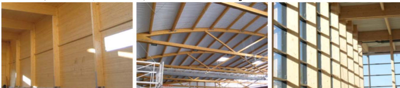
Abb. 3: Wandflächen aus Holz; Tragwerk (gekrümmter Fachwerkträger) mit Trapezblech als Deckung; Fassadenelemente aus Glas
